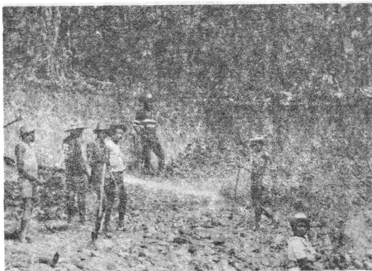
Explotación por Motobomba y Monitor. Minas Gertrudis-Barbacoas
