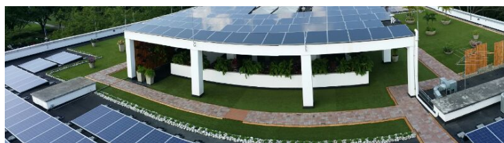
Figure 4.14: Sistema fotovoltaico edificio EPSA Yumbo
