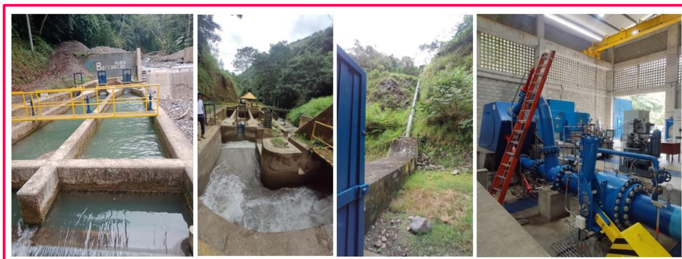
ILUSTRACIÓN 1: CENTRAL HIDROELÉCTRICA DE BARRANCAS
