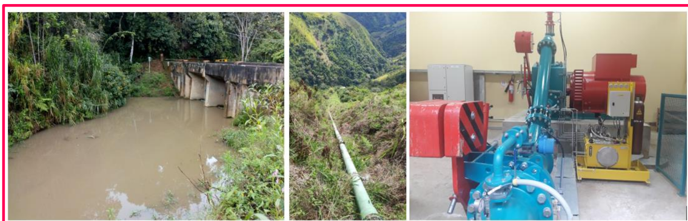
ILUSTRACIÓN 2: CENTRAL HIDROELÉCTRICA COCUYÓ
