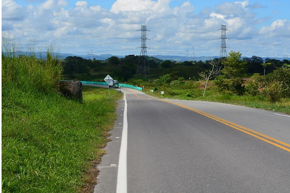
Ilustración 4.9 Tramo Transversal Tribugá – Arauca, sector Puerto Olaya, INVIAS
