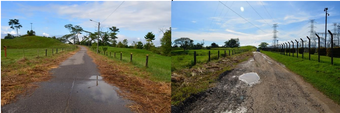
Ilustración 4.10 Vía veredal de acceso a la subestación Primavera – tramo pavimentado y destapado
