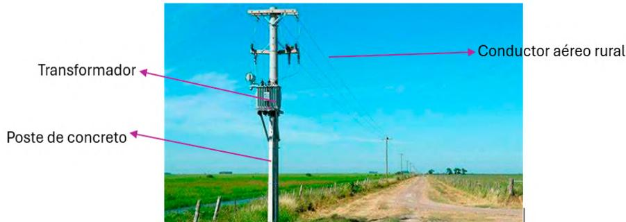
Figura 13. Activos típicos de un sistema de interconexión de OR.
