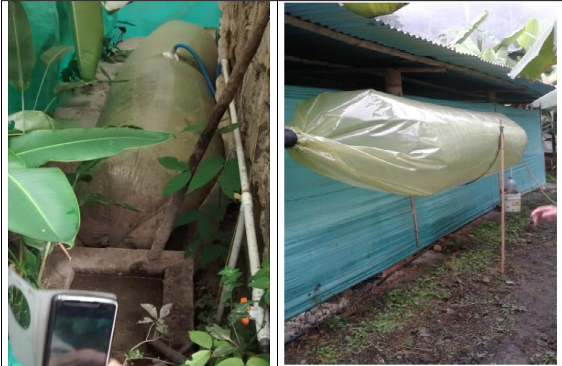
*Ilustración 6. Biodigestores tipo “salchicha” implementados de manera propia por los porcicultores. Fuente: PERS Cundinamarca.*
