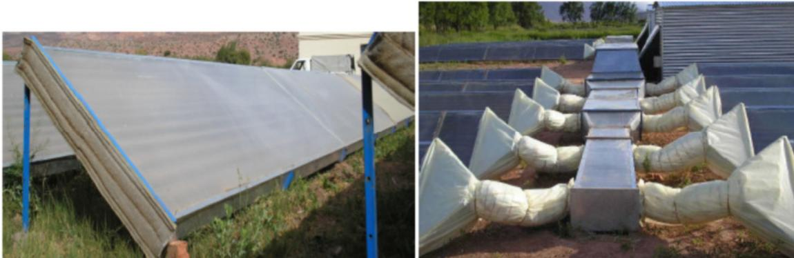
Figura 11. Foto del colector solar calentador de aire. Vista de las campanas de reducción y acople al caño maestro. Fuente: IV Conferencia Latino Americana de Energía Solar (IV ISES\_CLA) y XVII Simposio Peruano de Energía Solar (XVII - SPES), Cusco, 1 – 5.11.2010
