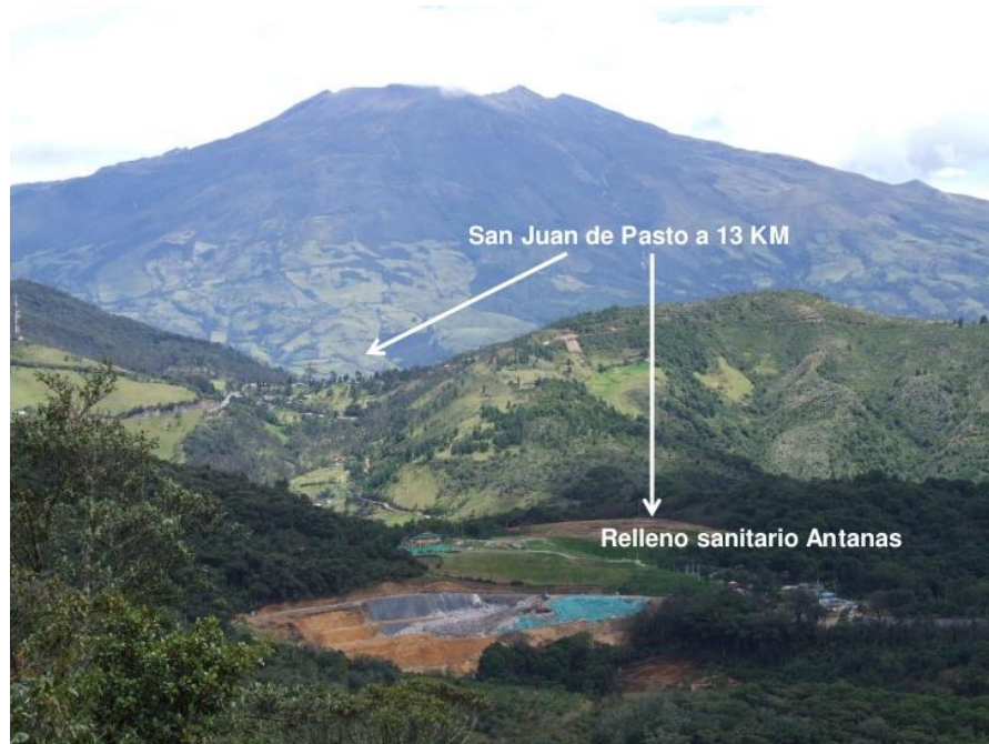
Fig.9. Relleno Sanitario Antanas
