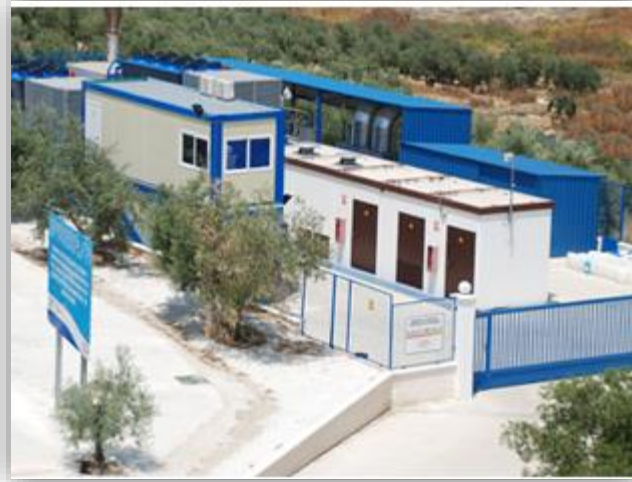
Fig.16. Instalaciones del vertedero en Montalbán
