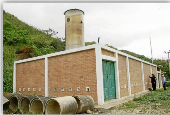
Fig.10. Planta desgasificadora en el relleno sanitario El carrasco
