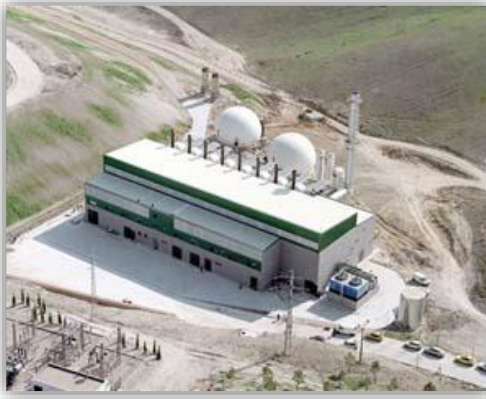
Fig.15. Planta desgasificadora y de energía eléctrica en el centro la Galiana
