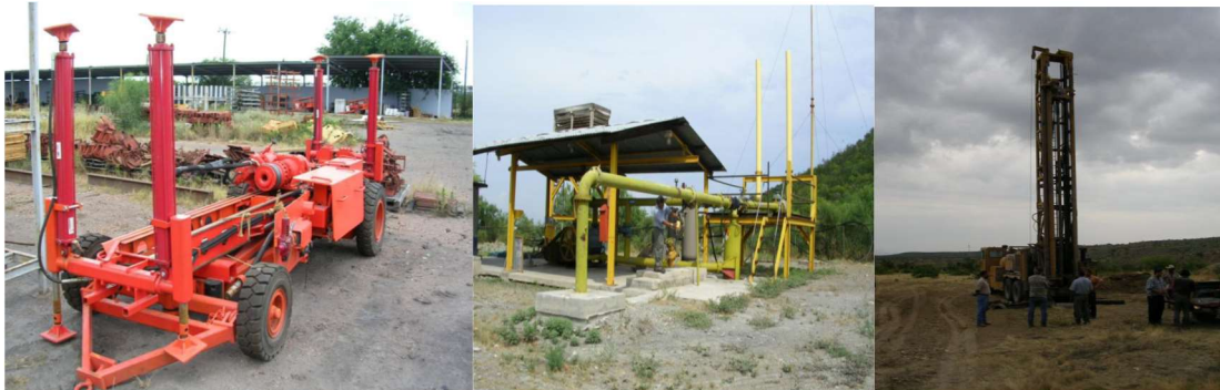
Figura 23. Izquierda, perforadora horizontal para CMM. Centro, ductos que llevan el gas a la superficie para su quema posterior. A la derecha, perforación vertical de zonas ya explotadas o derrumbadas (gobhole).
