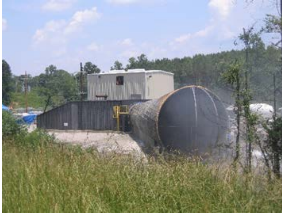
Figura 49. Ventilación con évasé a la salida de una mina subterránea de carbón.
