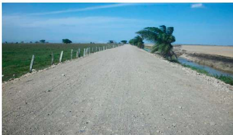
Figura 70. Estabilización mecánica. base granular.
