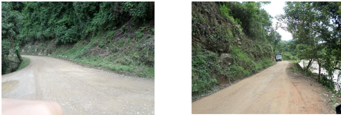
Ilustración 18 Característica del Pavimento Tramo El Tarra - Convención
