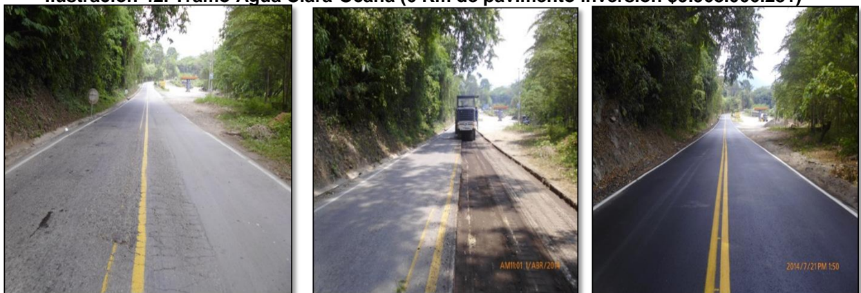
Ilustración 42. Tramo Agua Clara-Ocaña (6 Km de pavimento inversión $9.968.066.281)
