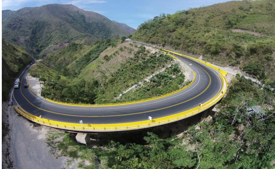
Ilustración 47. Viaducto NN (inversión $6.749.013.751)
