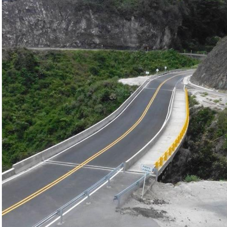
Ilustración 49. Viaducto La Batea (inversión $8.288.540.893)
