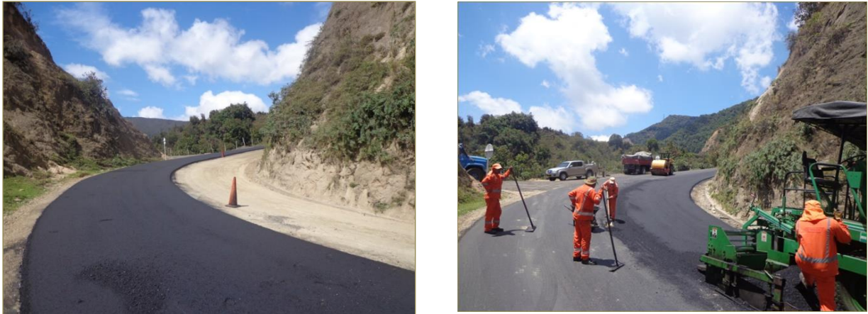
Ilustración 43. Tramo Ocaña-Alto del Pozo (4,5 Km de pavimento inversión $12.809.510.000)
