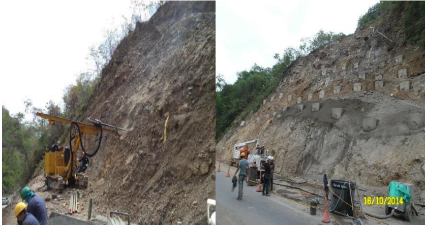
Ilustración 39. Tramo Alto El Pozo-Sardinata
