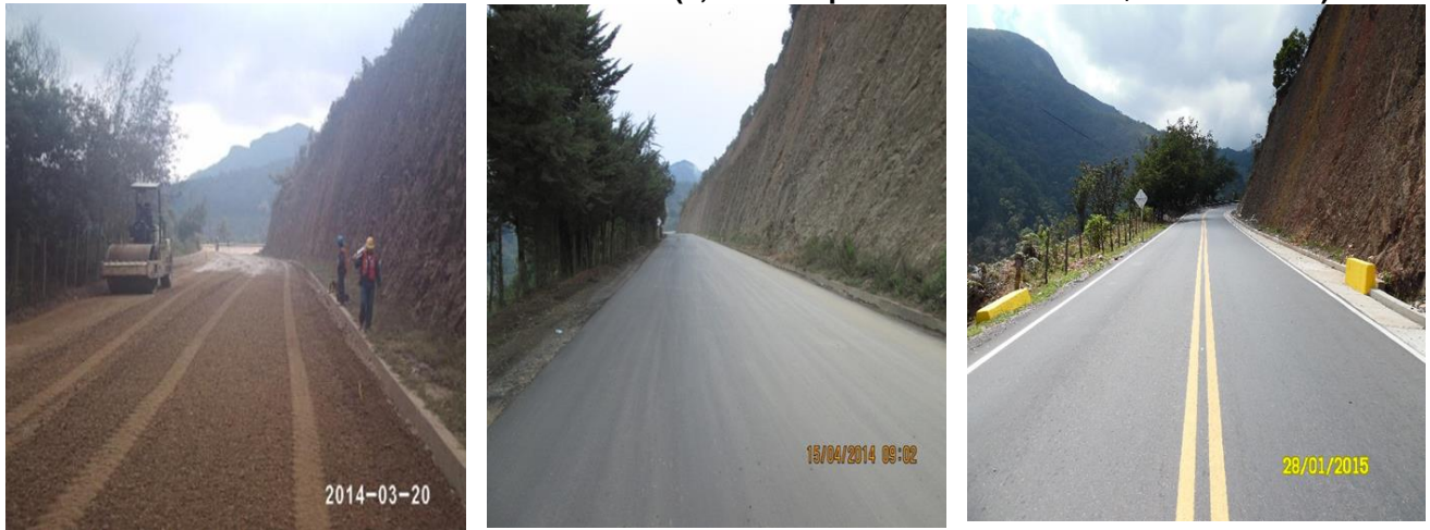
Ilustración 44. Tramo Alto del Pozo-Sardinata (3,2 Km de pavimento inversión $7.553.070.645)
