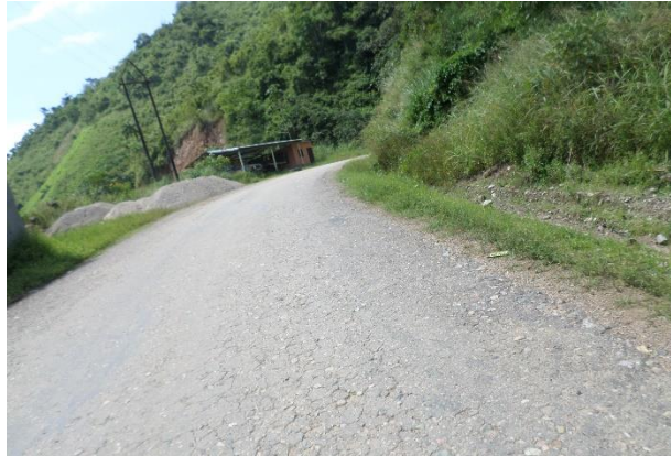
Ilustración 19 Característica del Pavimento Tramo El Tarra - Convención
