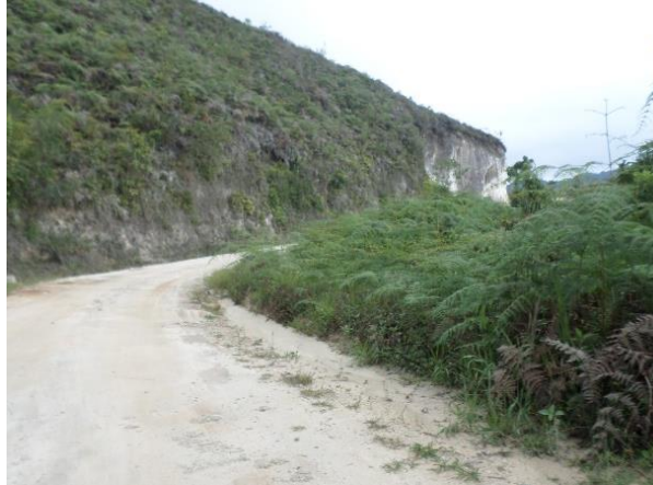
Ilustración 5 Estado Superficie de Rodadura Tramo Convención – La Mata Deslizamiento
