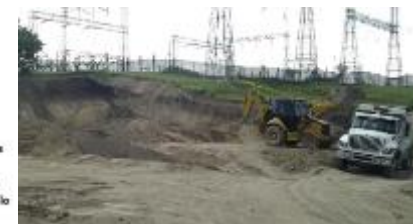
Actividades de explanación en la zona de autotransformadores
