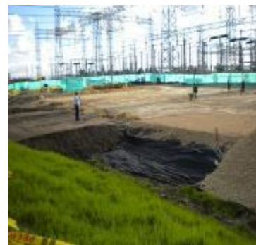
Explanación en Nueva Esperanza. Excavaciones para cárcamos y cunetas
