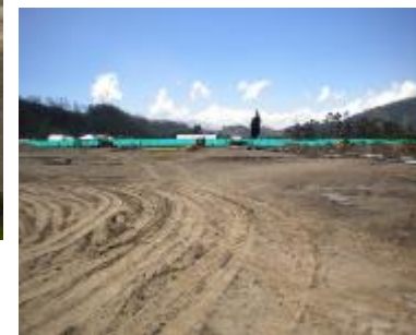
Lote de la subestación explanado en Bacatá
